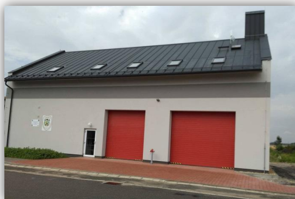
Zrekonstruovaná hasičská zbrojnice
